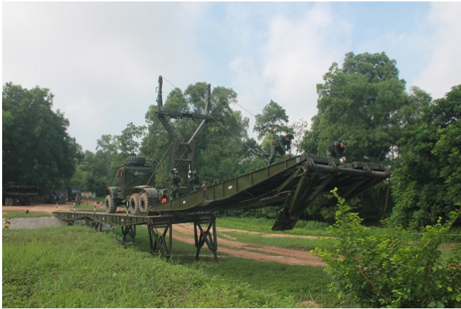
Hình 1. Quá trình bắc cầu TMM-3M ở giai đoạn hạ chân trụ trung gian
