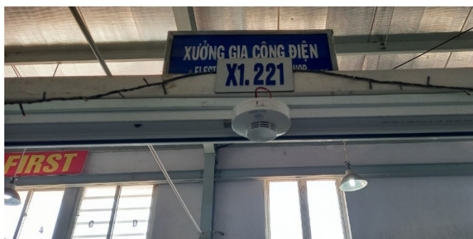
Hình 3. Một vị trí lắp đặt thực tế của đầu báo cháy tích hợp trong nghiên cứu. Một số trạng thái của hệ thống được xây dựng như:
