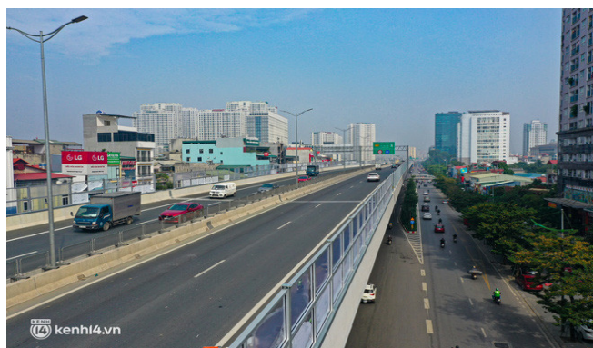
Hình 1. Hàng rào hấp thụ tiếng ồn ở các tuyến đường cao tốc trong các khu đô thị (nguồn: https://kenh14.vn )
