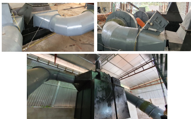
Hình 6. Một số hình ảnh về kết quả lắp đặt và chạy có tải: kết nối với hệ thống sấy sàn phẳng quy mô 60 - 80 tấn sấy bằm tươi/mẻ
