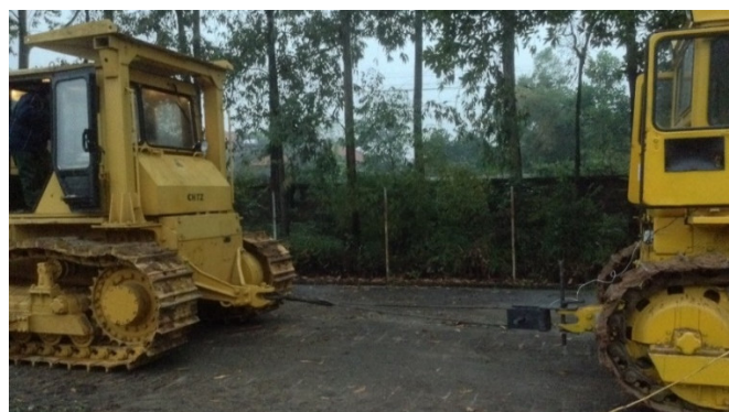
Hình 7. Hoàn chỉnh lắp đặt, tiến hành đo lực kéo
