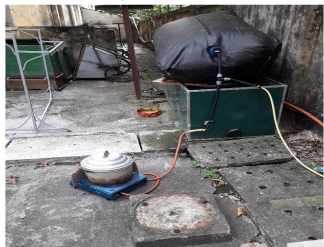
Hình 11. Lắp bếp đun thử nghiệm
