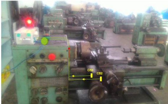
Hình 14. Thiết bị được lắp đặt chạy thử trên máy tiện 16B05П
